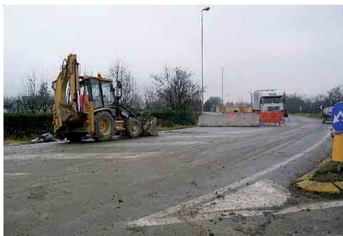
Il cantiere della Pedemontana a Scandiano
