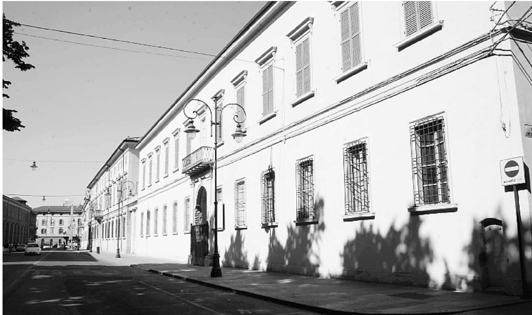
Palazzo Allende, sede della Provincia di Reggio
