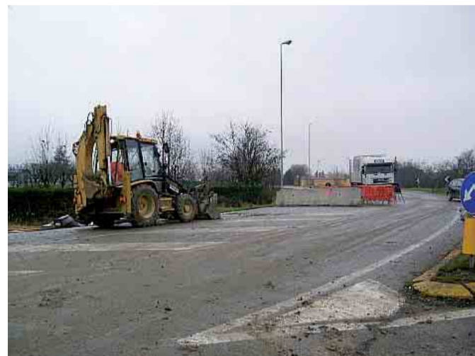
I lavori sulla Pedemontana di Scandiano
